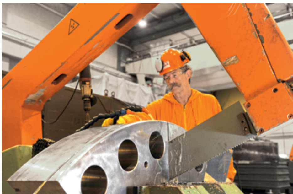
↑ SCHWERES GERÄT: Die Kollegen im Technologiezentrum auf dem Gelände des Kernkraftwerks Gundremmingen sind erfahrene Rückbau-Experten.
